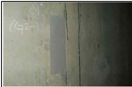
시점교대 흥벽 보수현황
